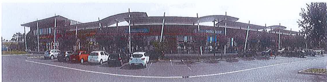
Figure 17 : Photographie prise depuis la route de Sens (RD605) (réalisation CDHU)
