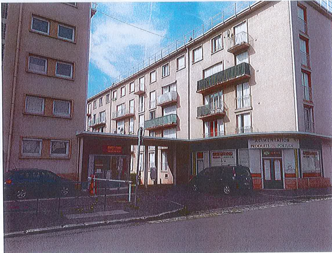
Figure 15 : Photographie prise depuis la rue de Varennes (réalisation CDHU)
