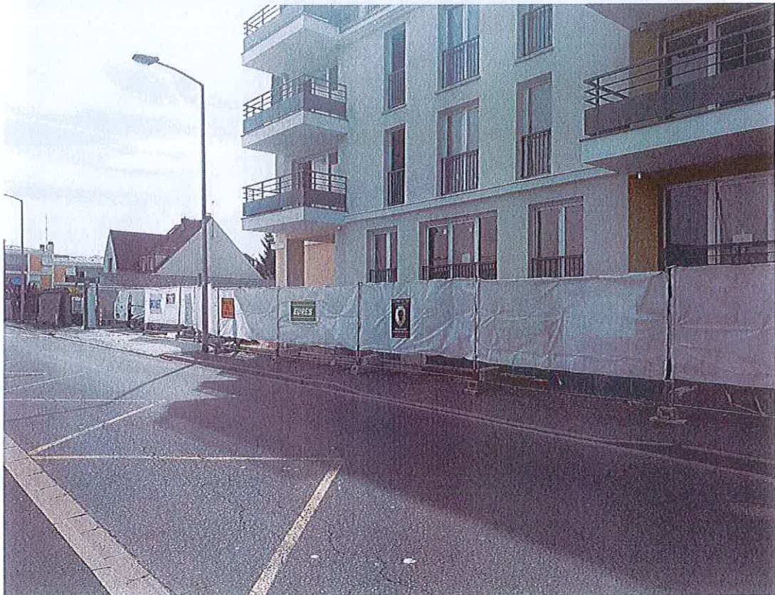
Figure 7 : Photographie prise depuis la rue des Prés Rebours (réalisation CDHU)
