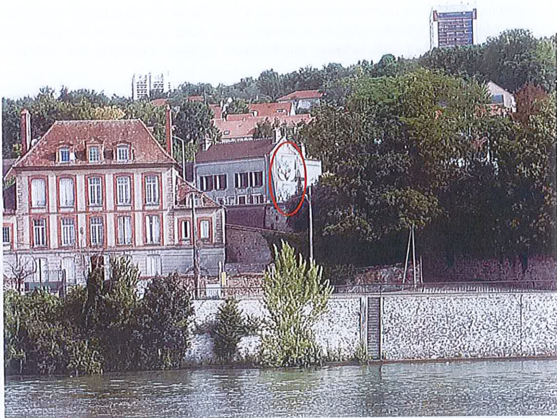
Figure 10 : Photographie prise depuis les quais d'Yonne (réalisation CDHU)
